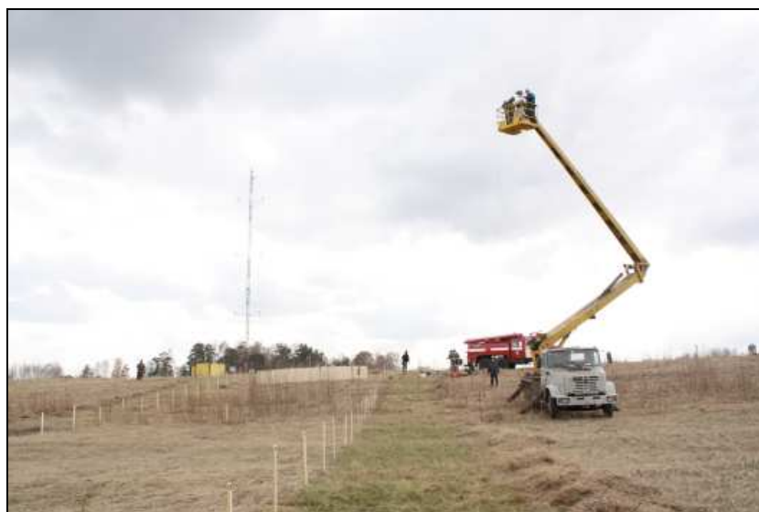
Рис. 1. Вид экспериментальной площадки с установленными деревянными щитами.
